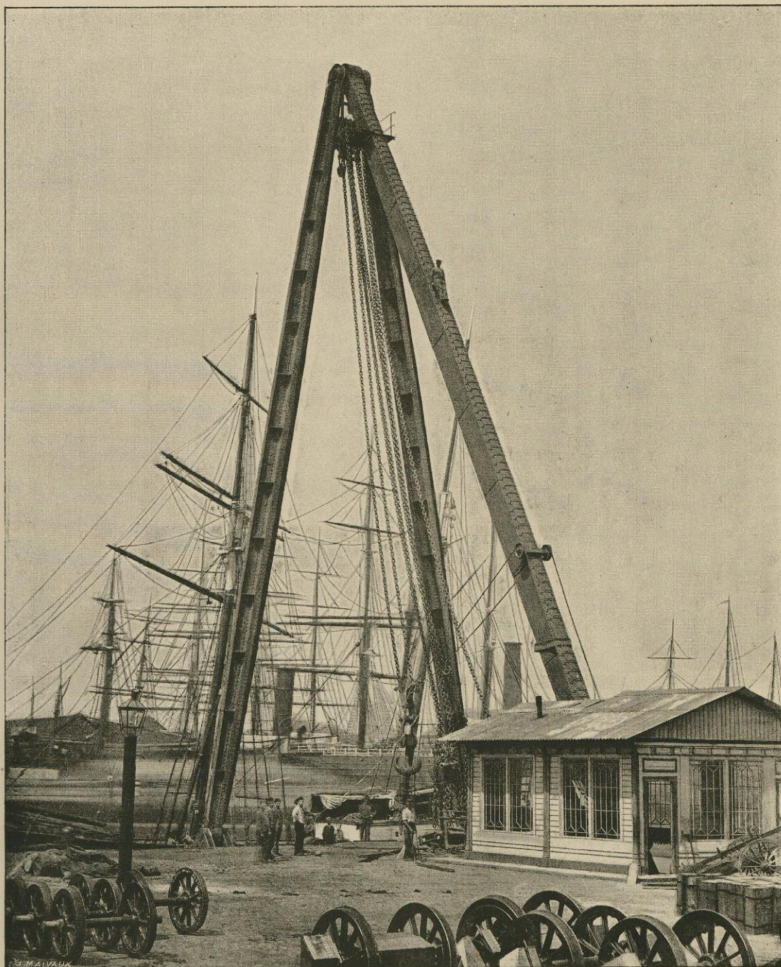
BIGUE DE 120 TONNES DU BASSIN KATTENDYK.
